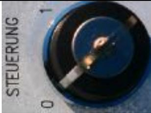
A blue rotary switch with a metal key inserted. The switch has two positions, '0' and '1', with the word 'STEUERUNG' printed vertically to the left. | Schlüsselschalter STEUERUNG<br><br>0 Steuerung ausgeschaltet.<br>Primärstromkreis im Steuerkasten steht unter Spannung<br>1 Steuerung ist eingeschaltet |
